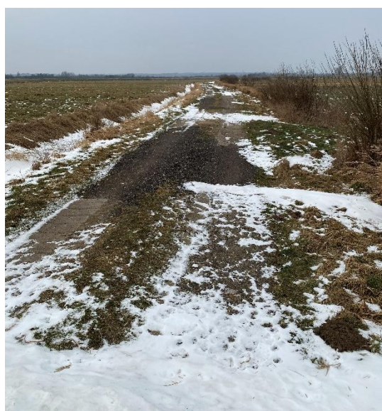
Abbildung 12: Plattenweg nahe der Treene, Quelle: inspektour GmbH 2026
